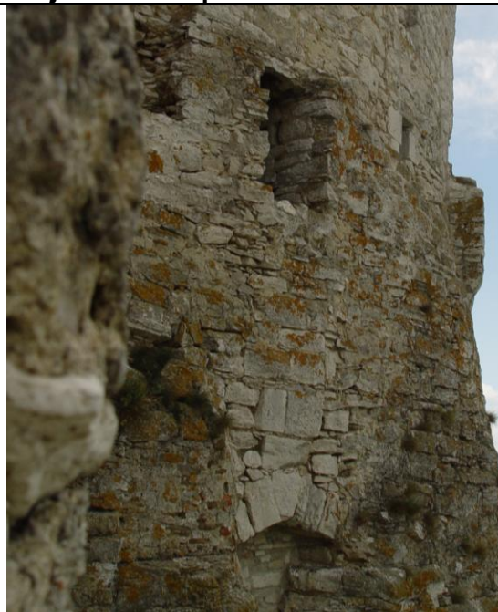
exteriér, Vyústenie prevétu hranatým otvorom v záklenku z opracovaných travertínových blokov, ktorý prekleňuje dve skalné bralá
