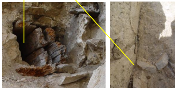
Drevená kapsa pre zat'ahovací trám rom. združ. okna ľavé armované ostenie rom. združ. okna , 1 omiet. vrstva
