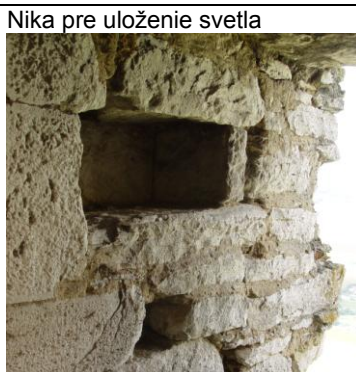
exteriér, Vyústenie prevétu hranatým otvorom v záklenku z opracovaných travertínových blokov, ktorý prekleňuje dve skalné bralá
