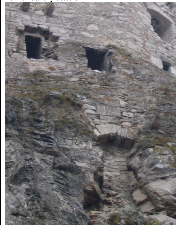
exteriér, Vyústenie prevétu hranatým otvorom v záklenku z opracovaných travertínových blokov, ktorý prekleňuje dve skalné bralá
