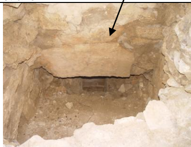
Detail – pohľad do vyústenia odpadovej diery z interiéru, nad otvorom kamenný travertínový preklad
