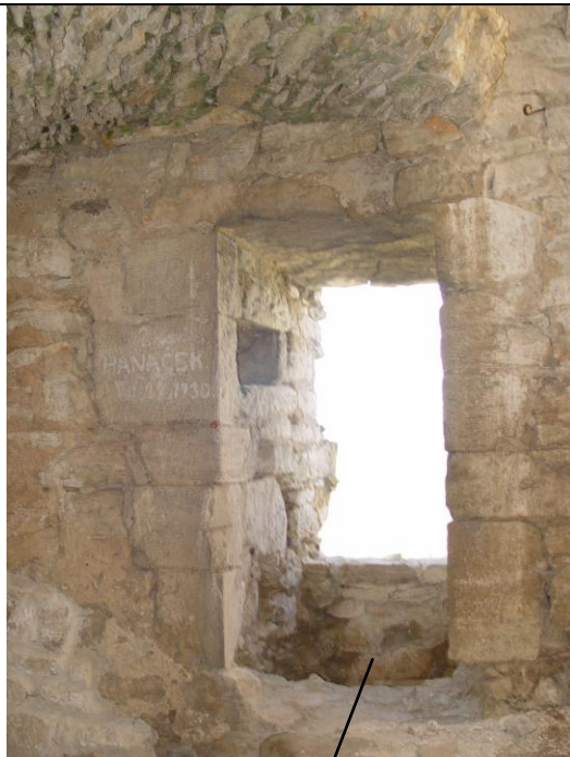
Prevét 1. NP románsky palác interiér PR/1 , 1. pol.13. stor. zo strany interiéru armované nárožia z opracovaných travertínových blokov s fazetou na hranách, nika na bočnej strane
